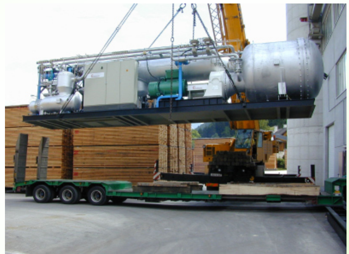
ORC Modul in Containerbauweise (400 kW el ) bei der Einbringung in eine Biomasse-Kraft-Wärme-Kopplungsanlage
