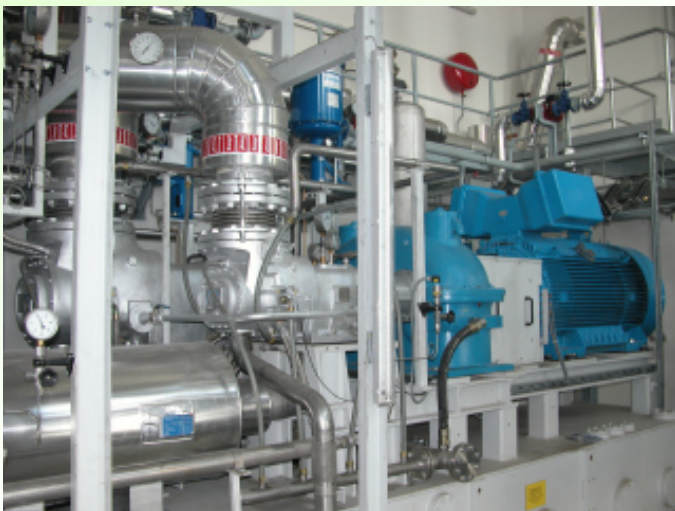
Dampfschraubenmotor (730 kW el ) in der Biomasse KWK-Anlage Hartberg
